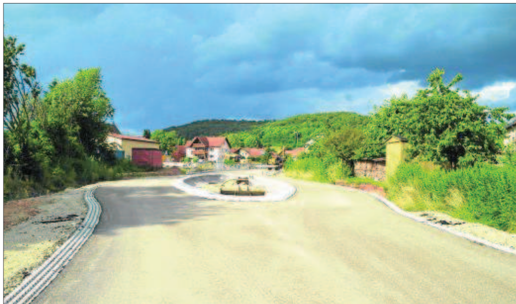
Das (noch) durch die Baustelle geteilte Roßbach.
